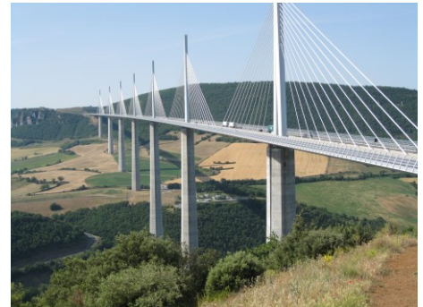
Viaduc de Millau
