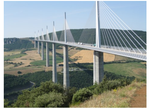
Viaduc de Millau
