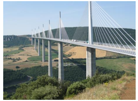
Viaduc de Millau
