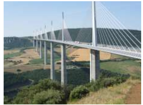
Viaduc de Millau
